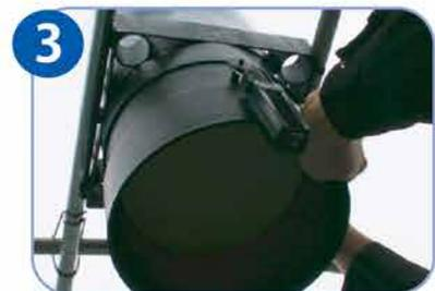
補助パイプを添えて空動扇を挟み込むように固定します。
