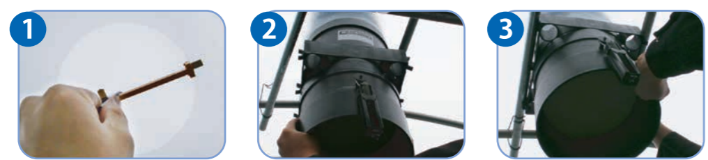
1 コンパスカッターを用いて直径15cmの穴を開けます。 2 空動扇を下からビニールに差し込みます。 3 補助パイプを添えて空動扇を挟み込むように固定します。
