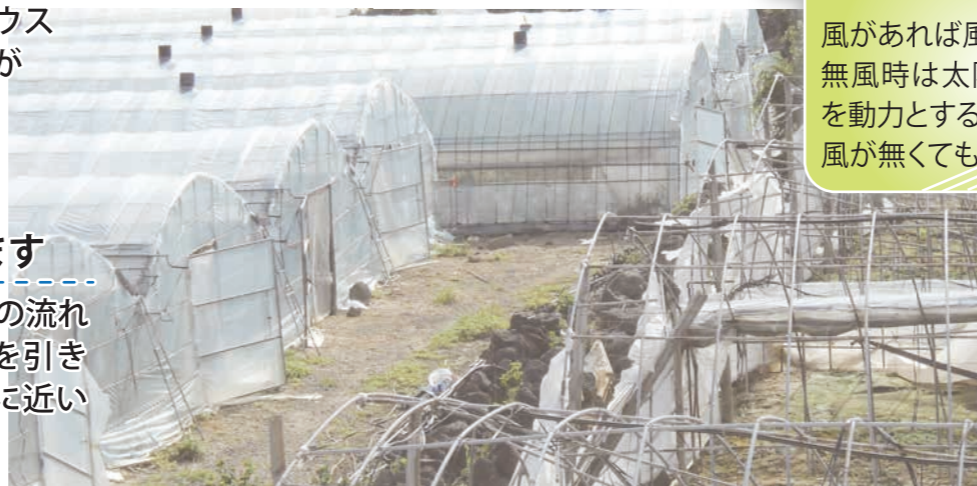
▲ 空動扇を設置したビニールハウス
